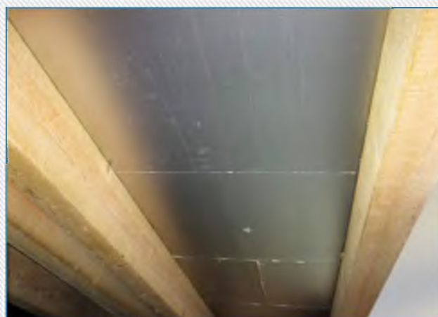
Fotografia 1: Strona wewnętrzna skośnego dachu z krokiewiami i warstwą izolacji
