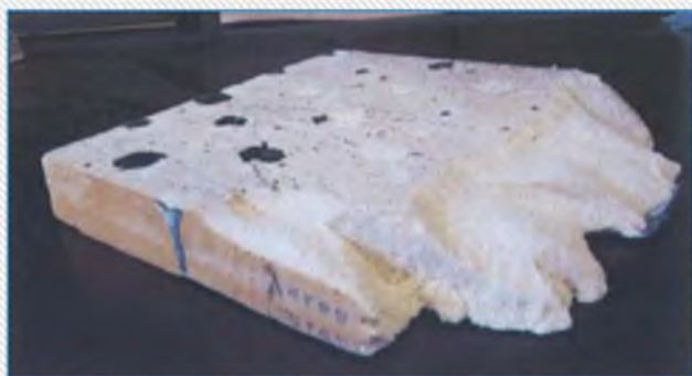
Fotografia 5: Próbką PU zdjętą z dachu płaskiego
