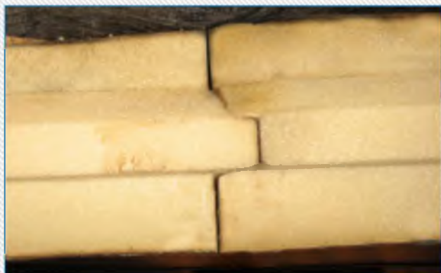
Fotografia 3: Płyty izolacyjne zamontowane szczelnie (ciasno) koło siebie
