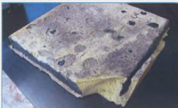
Fotografia 6: Próbką PU zdjętą z dachu płaskiego
